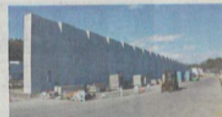
被災地で建設中の防潮堤 ―岩手県宮古市
